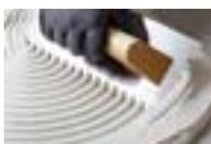
Aplicar con una llana dentada para regularizar el espesor en paños pequeños de máximo 2 m<sup>2</sup>. Respetar el tiempo abierto del adhesivo y en caso de que se haya formado una película en la superficie del adhesivo y no existe transferencia, eliminar el material y aplicar de nuevo. Efectuar un doble encolado para piezas de gran formato o elevado peso.
