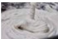
Amasar webercol flex2 multigel con la cantidad de agua limpia indicada en la tabla final, por saco de 25 kg, con un batidor eléctrico lento (500 rpm) hasta obtener una masa homogénea y exenta de grumos. Dejar reposar la mezcla unos 2 minutos y realizar un ligero reamasado.
