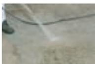
• El sustrato deberá estar asentado, seco, libre de polvo, grasa y demás impurezas que pudieran dificultar la adhesión. Si es necesario, el sustrato deberá ser tratado mecánicamente mediante abrasión mecánica tipo fresado, granallado o diamantado en función del soporte y posterior aspirado. • El soporte deberá tener una resistencia a la compresión mínima de 12 MPa y una resistencia a la tracción superior a 1,2 N/mm<sup>2</sup> (ensayo "pull-off").
