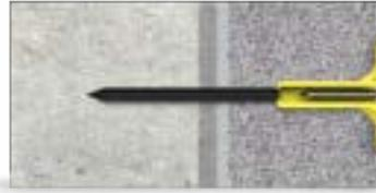
3. Posicionar el núcleo metálico roscado y atornillarlo hasta el correcto apriete del panel aislante.
