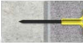
2. Insertar el cuerpo de la espiga en la perforación creada.
