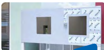
APLICACIÓN DE MORTERO PARA CAPA DE REGULARIZACIÓN
