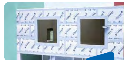
TRATAMIENTO DE JUNTAS CON PLACOTHERM® BASE
